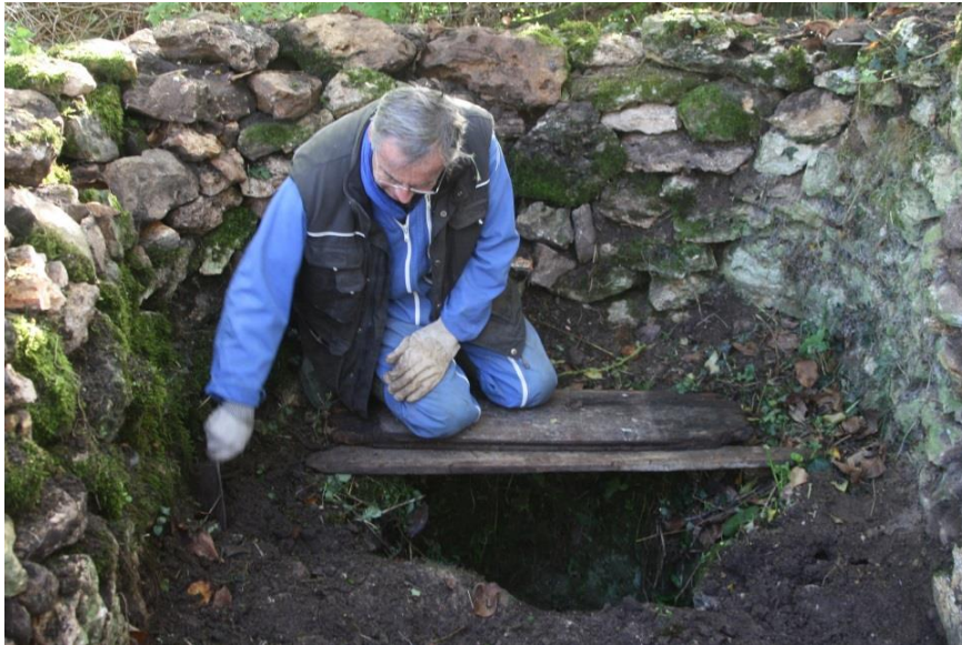
Dégagement de la terre accumulée sur les bords
