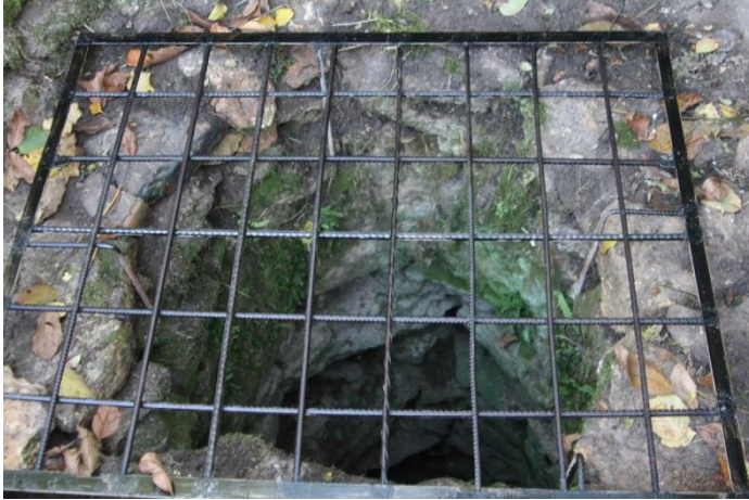
Grille encastrée dans l'ouverture sécurisant la fontaine.
