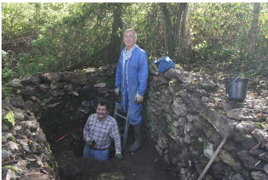
Réfection de la bordure de la fontaine
